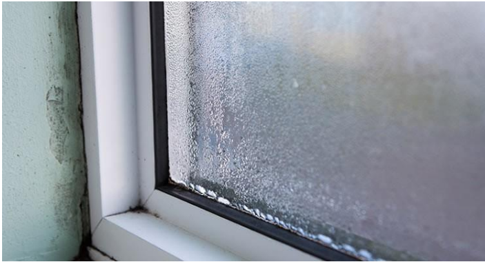
تصویر ۱۱-۴: افزایش رطوبت نسبی در پنجره و میعان
